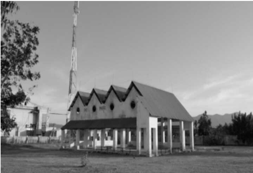
Hình 6: Một ngôi chợ ở Bác Ái, Ninh Thuận bị bỏ hoang từ nhiều năm nay do hình thức buôn bán ở chợ trung tâm không phù hợp với điều kiện, hoàn cảnh kinh tế - xã hội và văn hoá của người Ra-glai.
